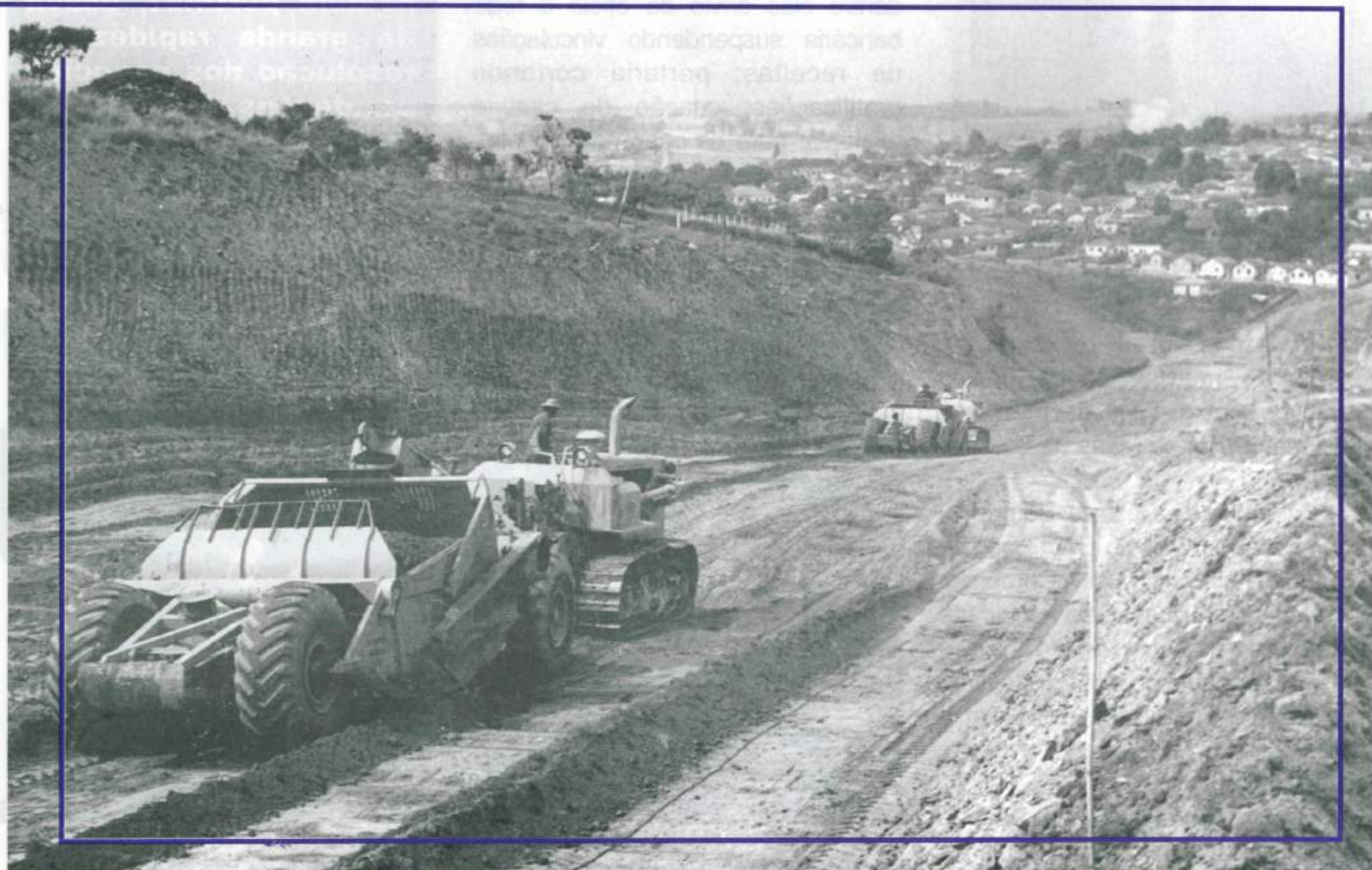
Serviço de terraplenagem, para alargamento da Av. Senador Montandon, novo acesso à BR 262. Acervo da Família.
