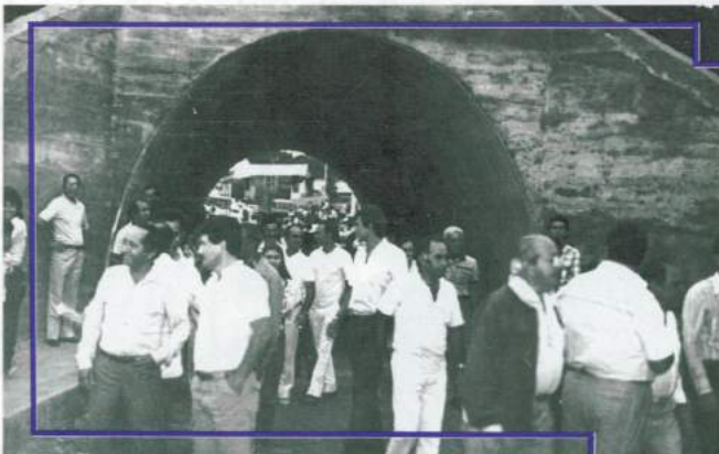
Construção e inauguração do túnel da R. Pepururé. 1983/1985. Arquivo 04538/SAPP/FCCB.
