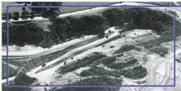
Obras do Aterro Sanitário de Araxá. Arquivo Prefeitura Municipal de Araxá.
