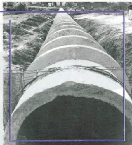
Canalização do Córrego do Santa Terezinha. 1989/1992. Acervo da Família.
