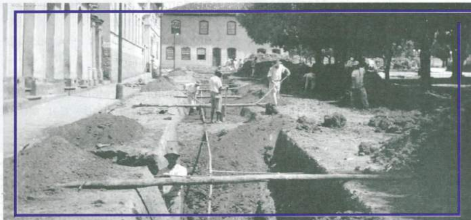
Serviço de canalização e distribuição de água da praça Coronel Adolpho. 1940/1945. Arquivo 00142/SAPP/FCCB.
