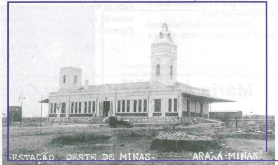
Estação Ferroviária Oeste de Minas. Década de 20. Arquivo 00337/SAPP/FCCB.
