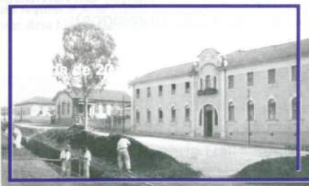
Serviço de canalização e distribuição de água, na praça São Domingos. Na lateral direita vê-se o Colégio São Domingos 1940/1945. Arquivo 00144/SAPP/FCCB.
