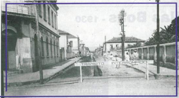
Serviço de condução de água na R. Pres. Olegário Maciel. Ao fundo, à esquerda, vê-se a Casa Mineira. 1932. Arquivo 00240/SAPP/FCCB.
