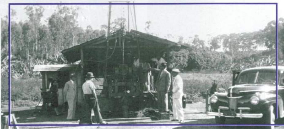
Poço Artesiano nº. 03 para captação de água. 0945/1945. Arquivo 00138/SAPP/FCCB.
